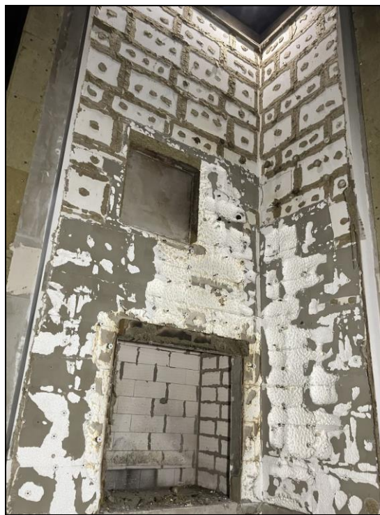
Obrázek 7 – Zkušební vzorek zdvojeného ETICS po zkoušce, po demontáži nového ETICS z minerální vlny a vnějšího souvrství původního ETICS z EPS
