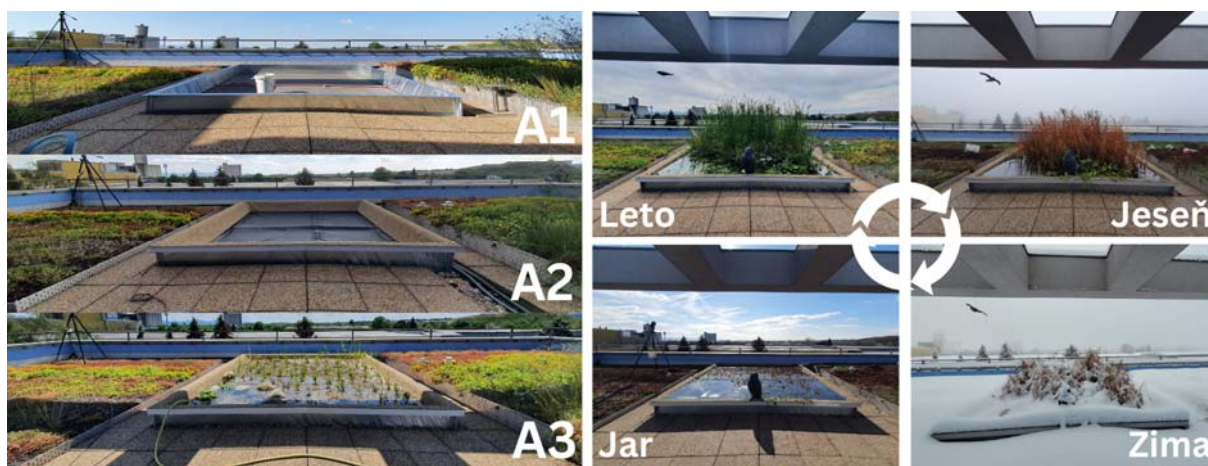
Obrázok 3 – Fotografie z realizácie experimentálnej mokraďovej strechy: A1 - osadenie ocelového rámu, A2 - aplikácia jazierkovej fólie s polystyrénovými nábehmi po obvodu rámu, A3 - výsadba vegetácie a naplnenie vodou. Vpravo - fotografie mokraďovej strechy počas štyroch ročných období.
