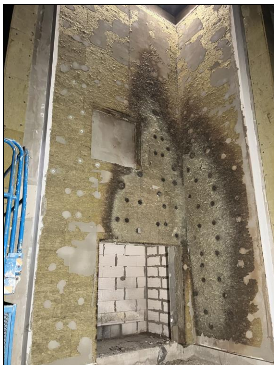
Obrázek 6 – Zkušební vzorek zdvojeného ETICS po zkoušce a po demontáži vnějšího souvrství
