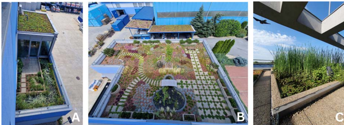
Obrázok 1 – Fotografie zrealizovaných úprav na terasách s mokraďovým strešným prvkom. A - západná terasa, B - severná terasa, C - experimentálna južná terasa.
