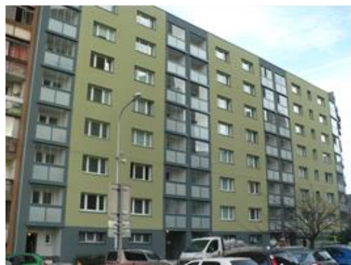
Pohľad na priečelie bytového domu po obnove
