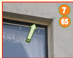
viditeľný pôvodný oceľový osadzovací rám
