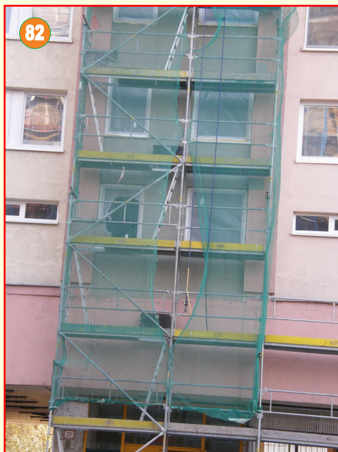
na schodiskách sa pôvodné copilitové sklené tvarovky nahrádzajú za plné parapety a nové plastové okná
