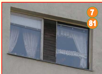
pohľad na pôvodné drevené okno
