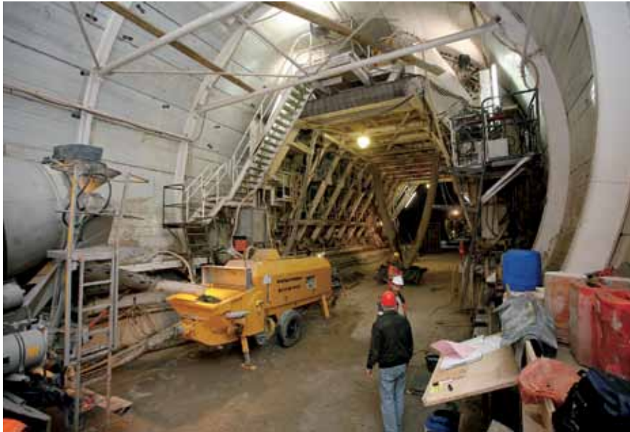
Obr. 11 Stabilné čerpadlo použité na betonáž ostenia tunela
