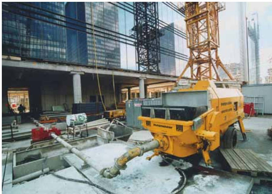
Obr. 9 Stabilné (stacionárne) čerpadlo čerstvého betónu
