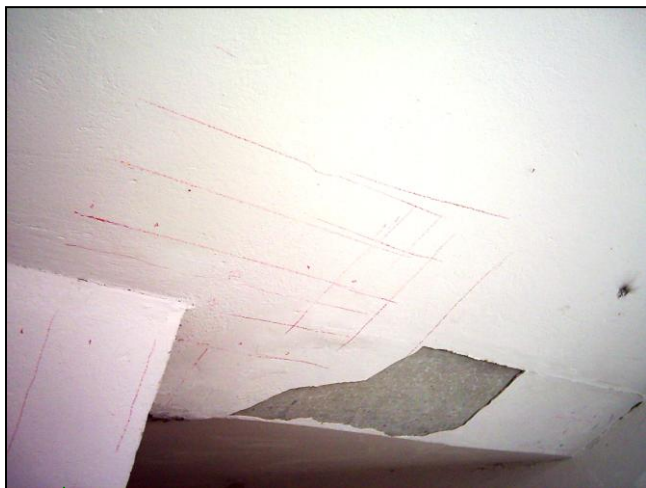
▲ Poloha výstuže vo vzťahu k otvorom pre kotvy Position of reinforcement in relation to openings for anchors
