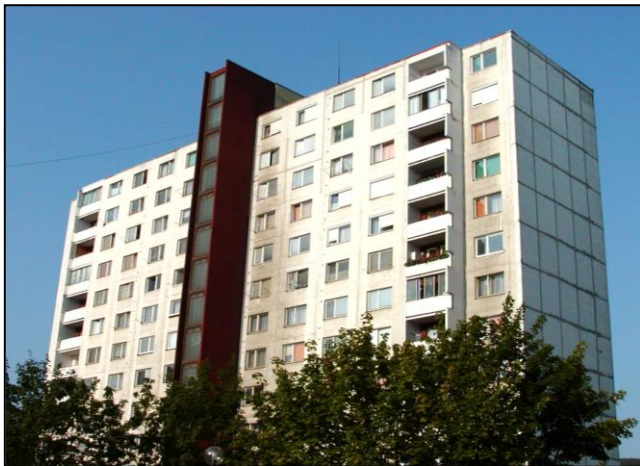
Pohľad na samostatný bytový dom ZTB (Galbavého 3) View of ZTB independent residential building (Galbavého 3)
