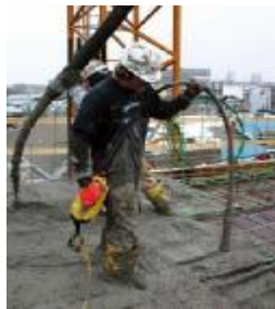
Obrázok 3: Vibrovanie ponorným vibrátorom čerstvý betónu na stavbe.
