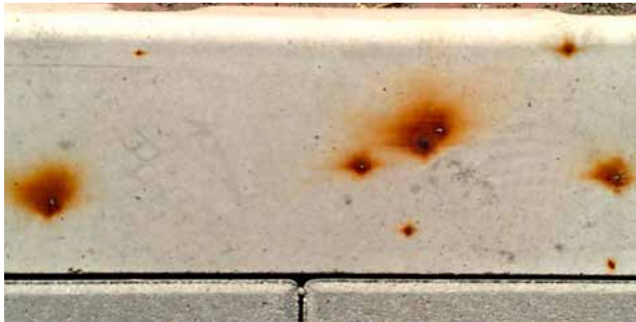
Obr. 16: Škvrnny hrdze na vláknotetónovom obrubníku
