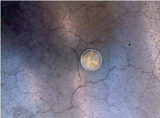
Obr. 7: Sieť jemných zmršťovacích trhlínok
