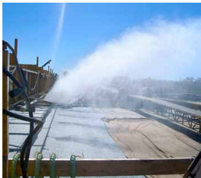
Obr. 7: Ošetrovanie vozovky pomocou generátorov hmly [13]
