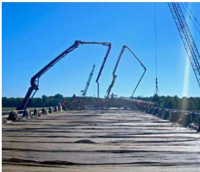
Obr. 4: Ošetrovanie mostovky kropením tkaninovej pokrývky [13]
