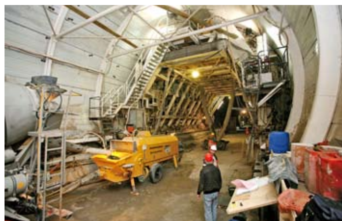
Obr. 13: Stabilné čerpadlo použité na betonáž ostenia tunela
