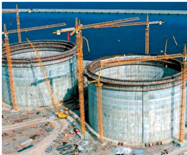
Obr. 15: Voľne stojace veže pri betonáži zásobníkov zemného plynu
