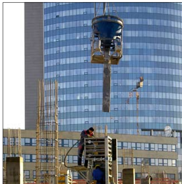
Obr. 7: Betonáž stĺpov s použitím bádie
