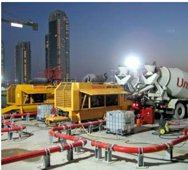
Obr. 14: Viacvetvový potrubný systém
