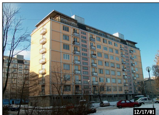
▲ Celkový pohľad na obnovený bytový dom na Piešťanskej ul. č. 5 – 7 General view on the upgraded dwelling house LB – structural system, Piestanska Str. No 5-7
